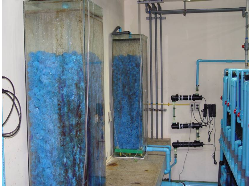
ภาพที่ 3 ตัวกรองแบบโปรยกรอง สำหรับระบบตู้เลี้ยงพ่อแม่พันธุ์ปลาการ์ตูน สถาบันวิทยาศาสตร์ทาง ทะเล มหาวิทยาลัยบูรพา
